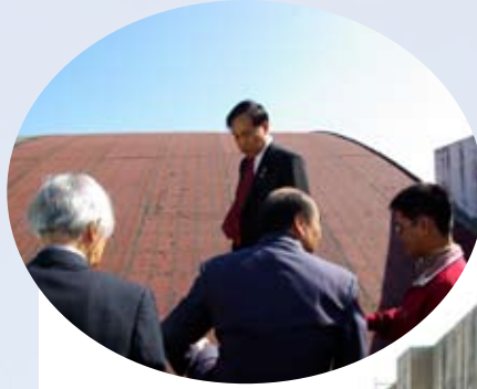
賴總監一馬當先至三樓屋頂勘察
